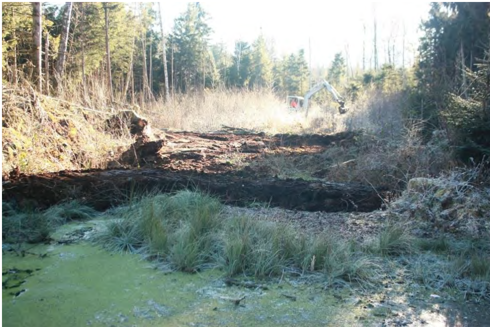
Abb. 73 Baggerarbeiten und Bau neuer Torfdämme im südlichen Teil des Langen Filzes im Dezember 2016 (Foto: H. Liebel).
