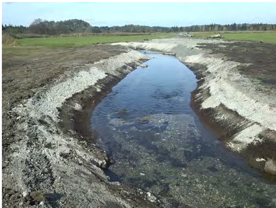
Abb. 80 Rechtach im neuen Bett nach der Entfernung des Rohres; Blick Richtung ehemalige Landebahn des Segelflugplatzes. Die steilen Ufer sollen noch abgeflacht werden (Foto: K. Streicher).
