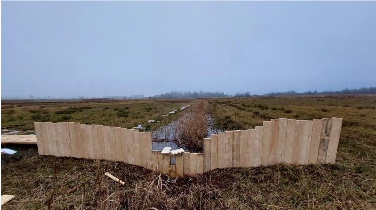
Abbildung 47: Anstau eines Wiesengrabens mit Nut & Federbrettern. Mittels verschiedener Messgeräte werden die Auswirkungen des angehobenen Grundwasserstandes überwacht (Foto: T. Korschefsky)
